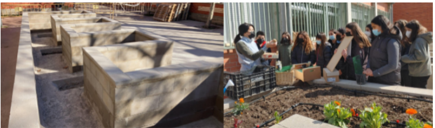
Bancales elevados alzados con bloques de hormigón. La altura desde el firme exterior es de unos 90 cm de altura. está perforado parcialmente la suela de hormigón, alcanzando un total de 1,20 de profundidad en algunas zonas del interior del bancal.
