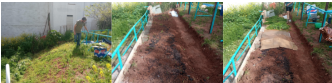
Proceso de realización de bancal en terrazas para salvar la pendiente
