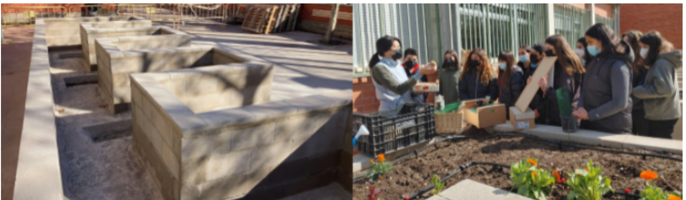
Bancales elevados alzados con bloques de hormigón. La altura desde el firme exterior es de unos 90 cm de altura. está perforado parcialmente la suela de hormigón, alcanzando un total de 1,20 de profundidad en algunas zonas del interior del bancal.
