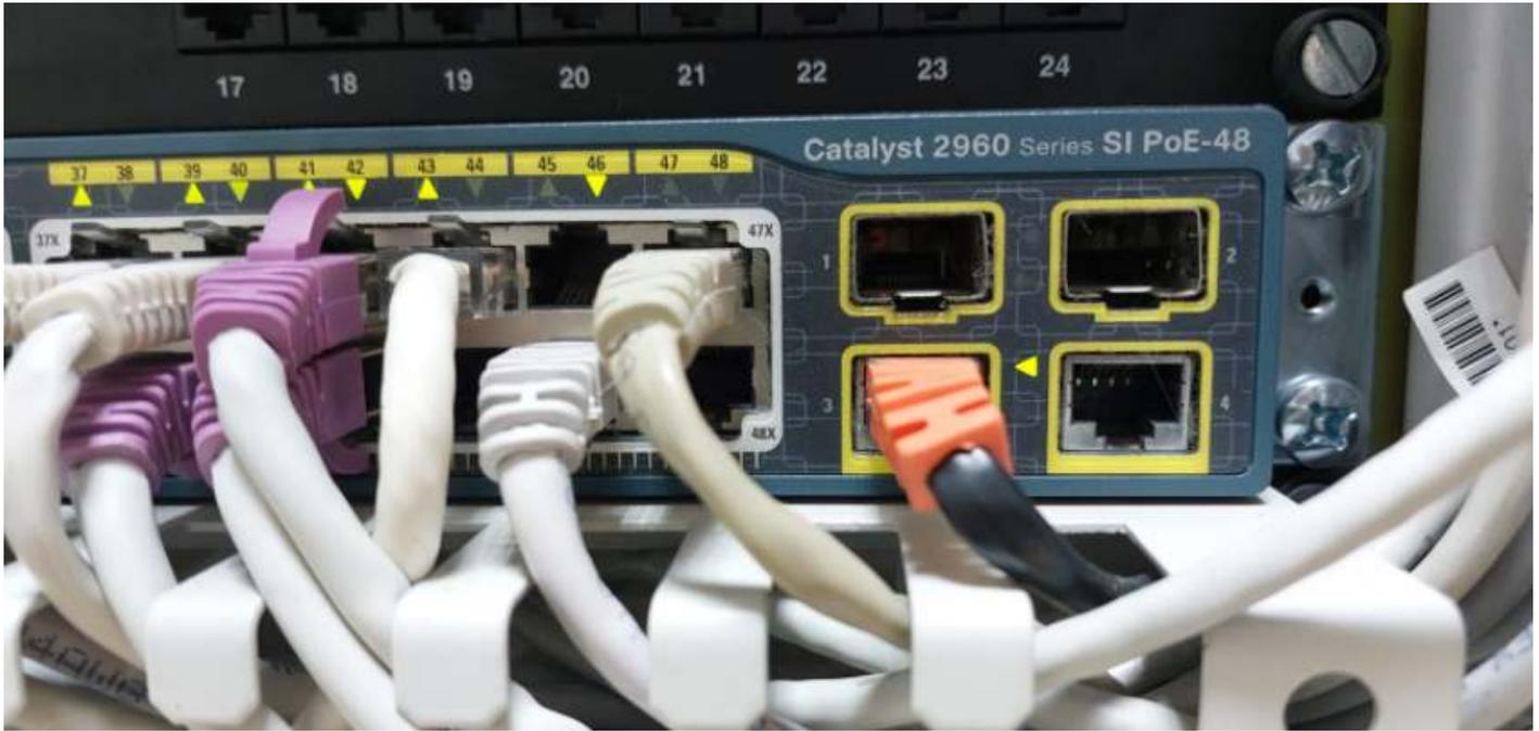
Esto nos facilita la instalación de dispositivos que necesitan datos y alimentación, pues sólo hay que llevar un cable entrelazado. Un ejemplo de dispositivo que necesita POE son los teléfonos IP (teléfonos que se van por la red de datos de Internet, no por la red voz tradicional)
